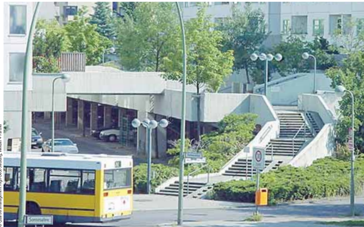
Die Neuköllner High-Deck-Siedlung, Paradeprojekt der 1970er-Jahre, wird zunehmend zum Sanierungsfall
